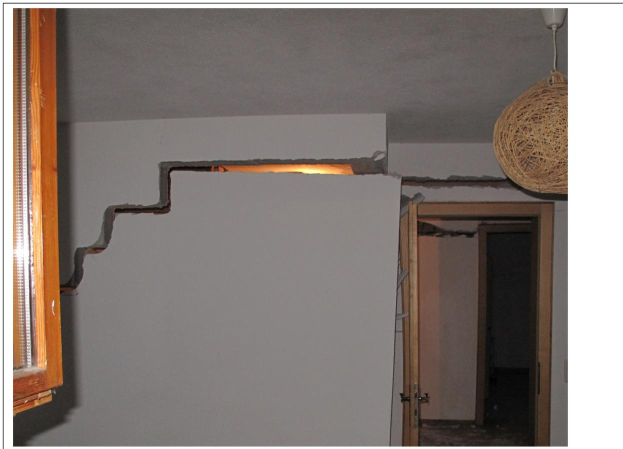
**Abb. 2:** Die Folgen des Erdalles waren Risse in sämtlichen Räumlichkeiten des Hauses, das abgebrochen werden musste.
