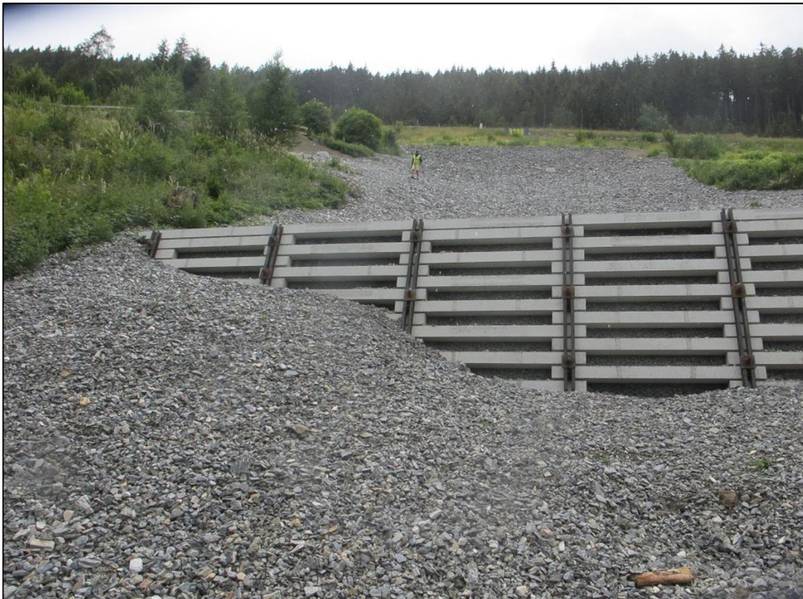
**Abb. 21:** Fertig abgedeckte Erosionsrinne
