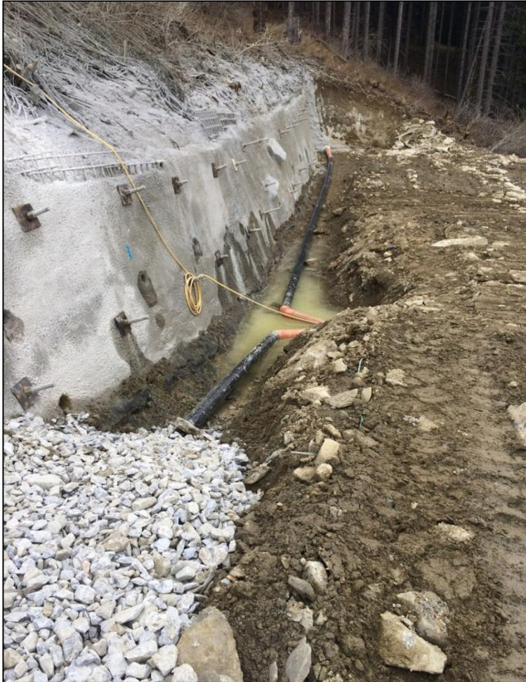
**Abb. 18:** Spritzbetonankerbalken
