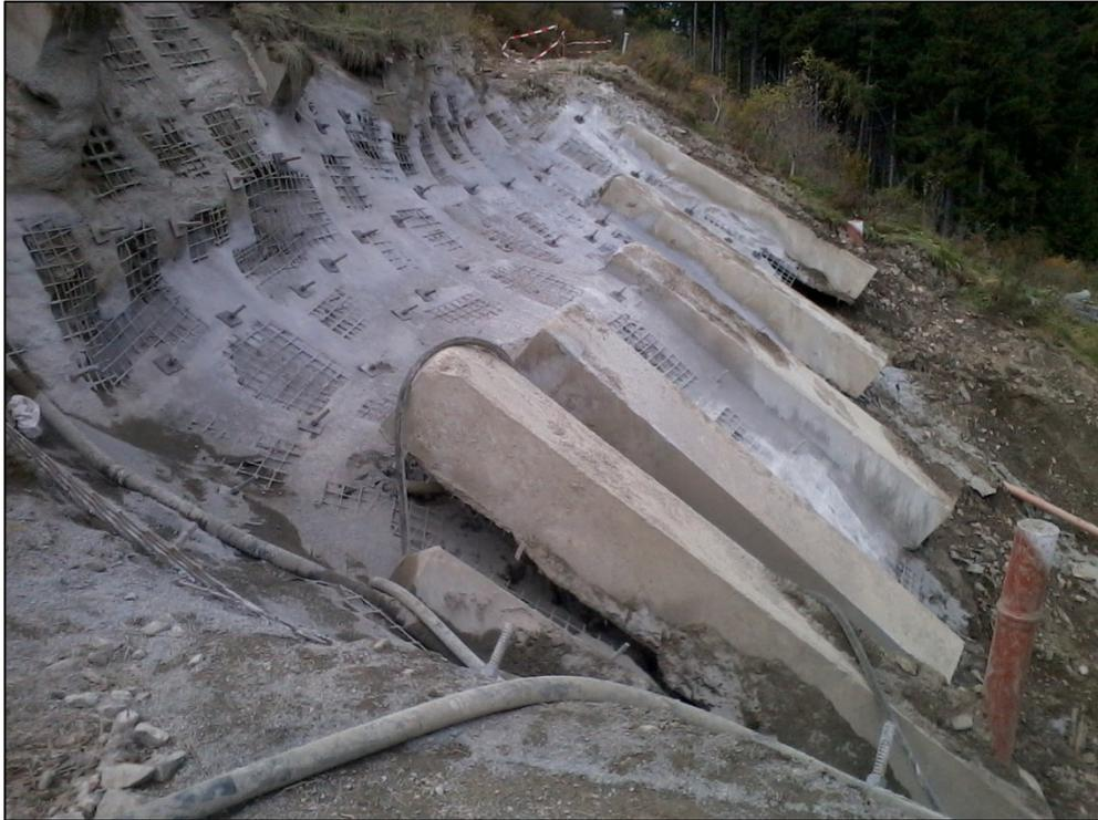
**Abb. 13:** Sicherung des Anbruches mittels offener Spritzbetonsicherung
